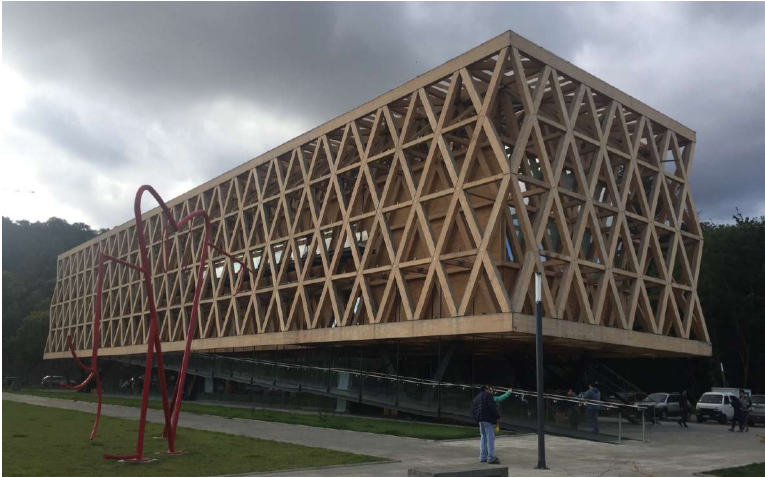
Visita Pabellón de Chile, Región de la Araucanía. Fuente: SIERRA, A. Técnicas y Procesos de Construcción en MASE UC 2018.12
