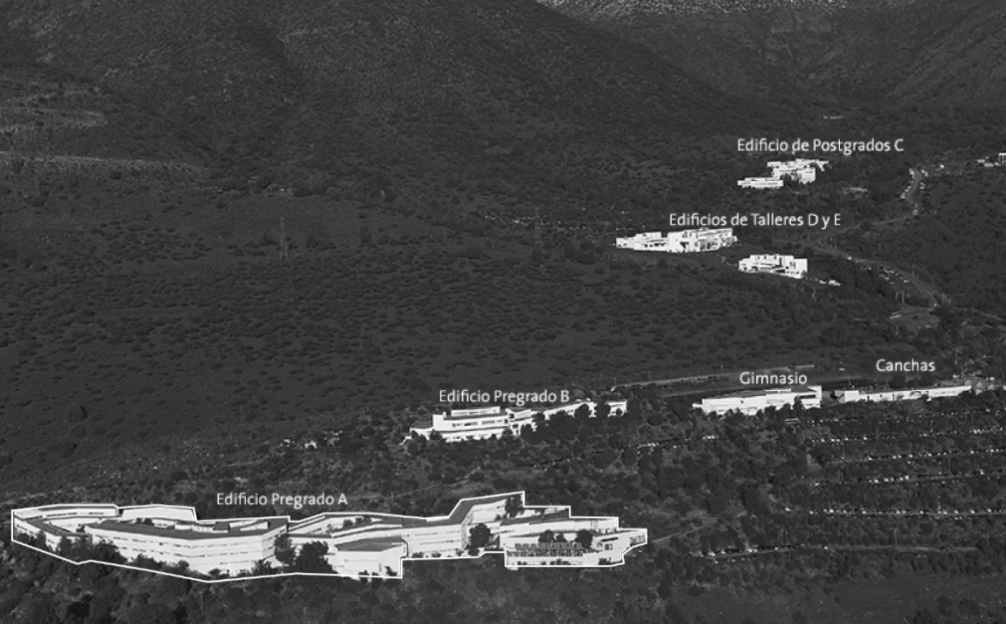
Fig. 2: Campus Peñalolén UAI La composición del campus incluye edificios construidos en diferentes etapas. El presente trabajo se abocará al edificio de pregrado.
