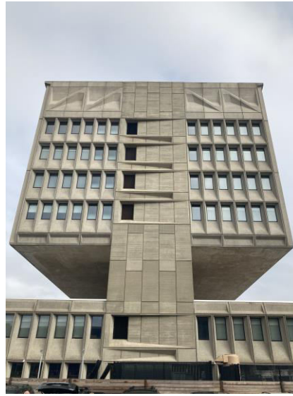
Marcel Breuer, Armstrong Rubber Co., New Haven, 1968. Ph: H. Torrent
